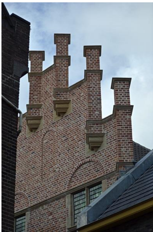
Reconstructie historische gevel Slot Oostende
